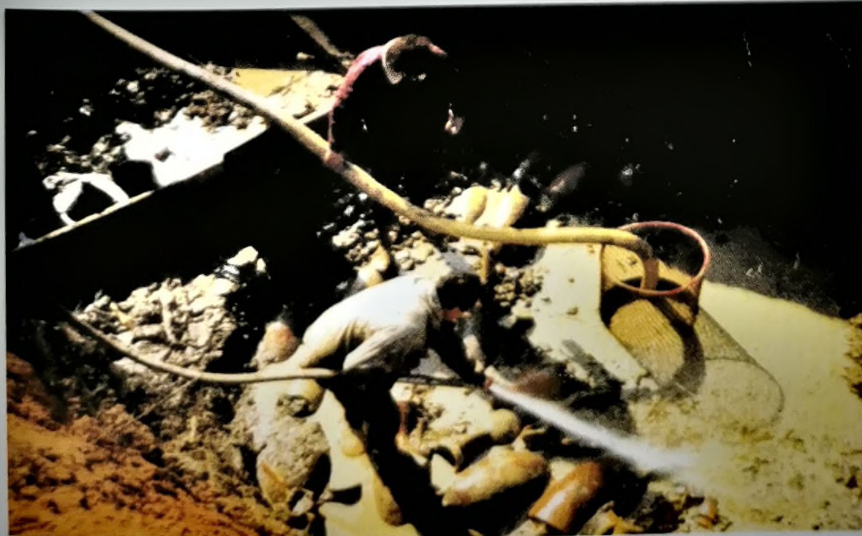
Dissolution des limons argileux au jet d'eau.
