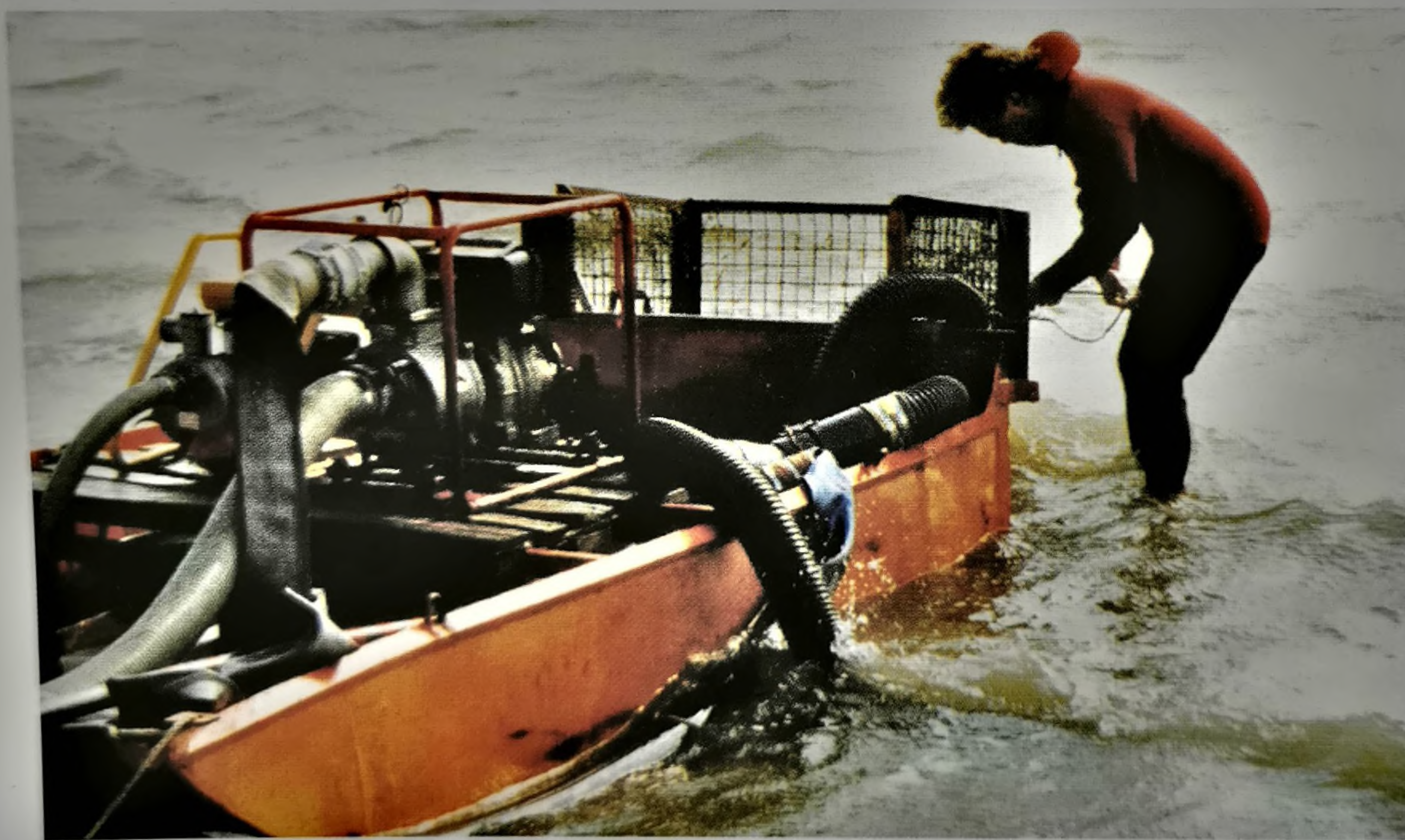
Moyens techniques d'aspiration et de filtrage.
