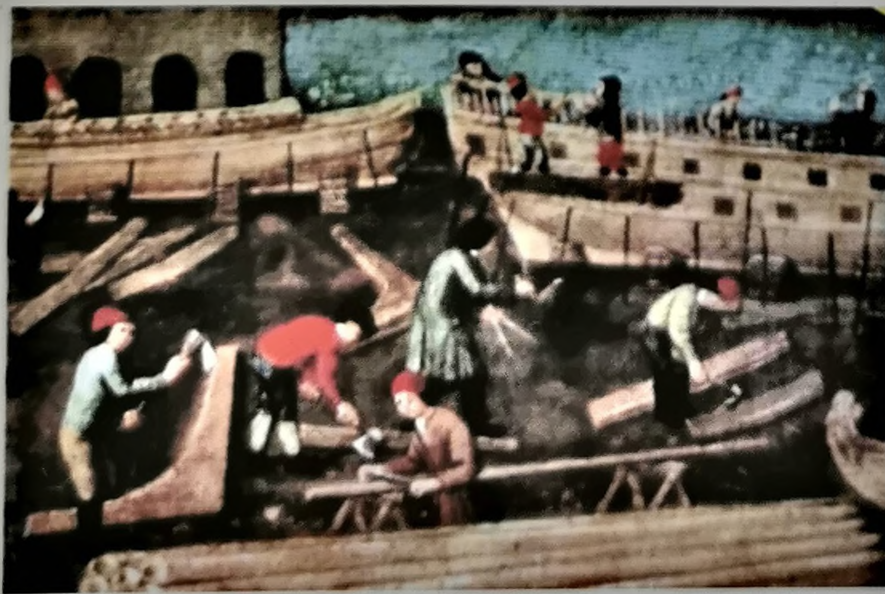
Chantier naval du XIV e siècle.
