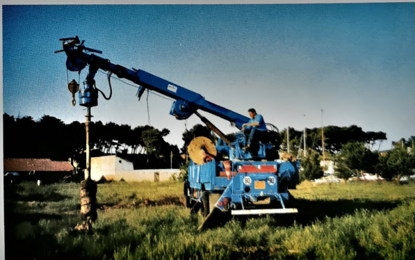
Localisation par carottages de l'emplacement du sondage par les services d'EDF.
