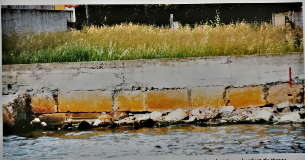
Certains grands blocs, de facture antique, ont été réutilisés en assises des chalets, en bordure du rivage.
