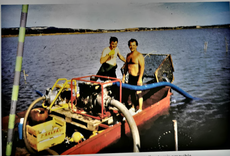
Barge métallique équipée de deux motopompes et d'un tamis amovible.
