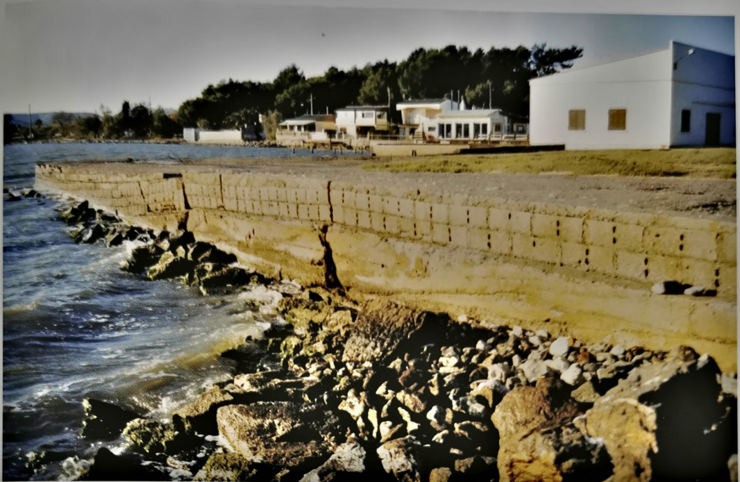
Etat actuel du quai moderne.
