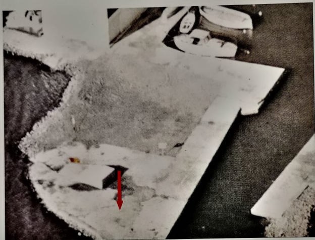
Jetée en béton réalisée dans les années 1960 – 1970.
