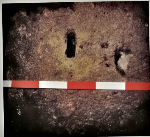
Orifice de levage appelé « trou de louve ».
