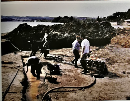
Découpage de la dalle en béton par l'équipe de fouille.
