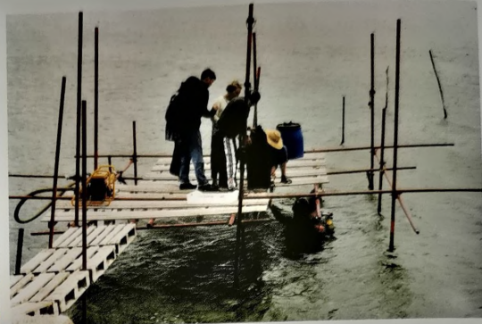
Montage du châssis en superposition du sondage supportant la plateforme technique.
