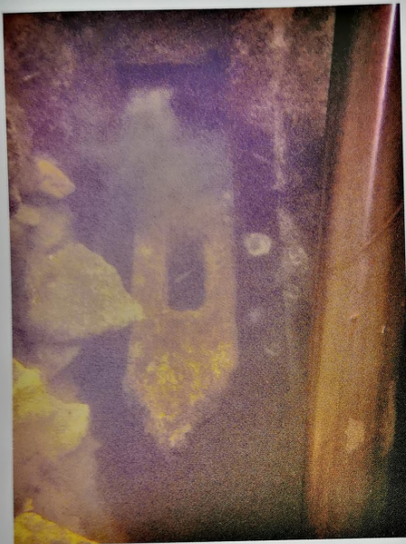
Coffrage extérieur : Vues d'une longrine, des madriers (dégagés jusqu'à -4.10 m) et des blocs des assises inférieures, par le passage de la longrine.
