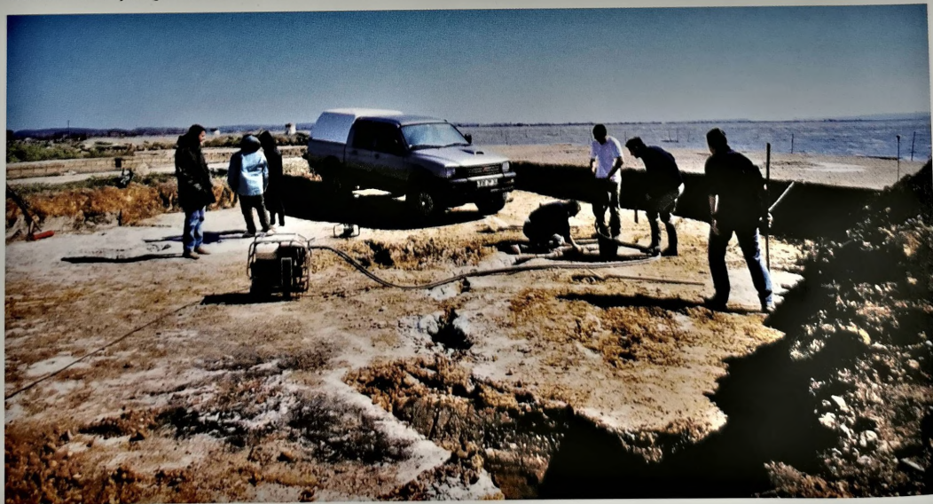
Réalisation de forages au travers de la dalle en béton.
