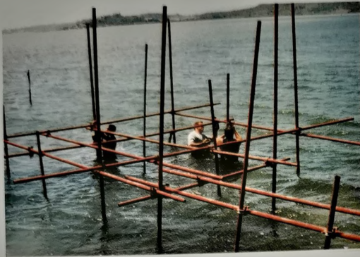
Montage du châssis en superposition du sondage supportant la plateforme technique.
