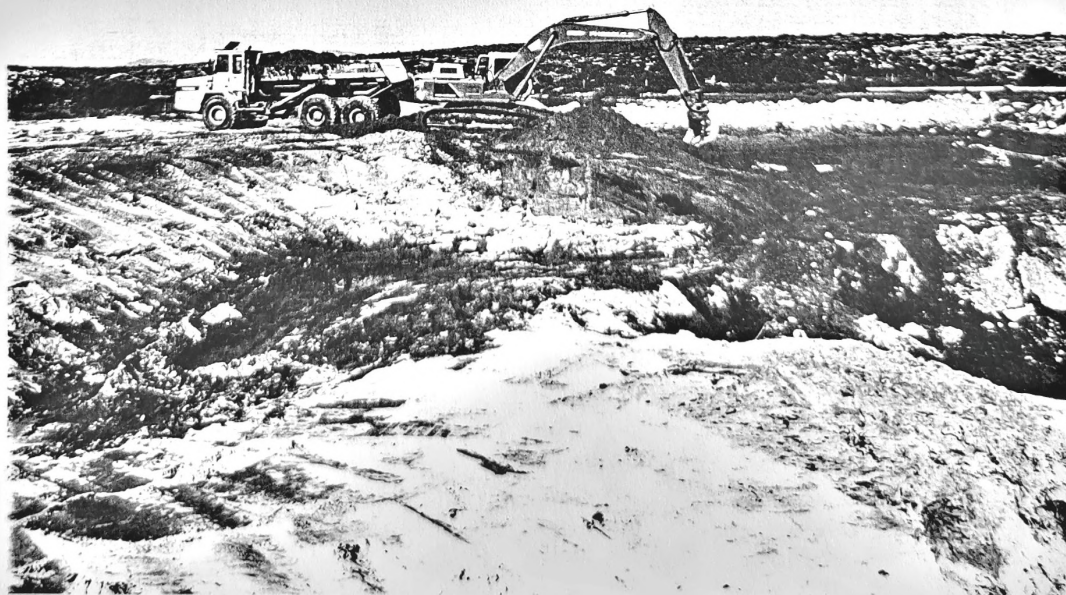
n° 2 : emplacement de la berge du canal anti-char
