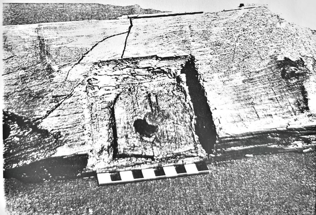
n° 2 : demi - languette chevillée dans une mortaise
