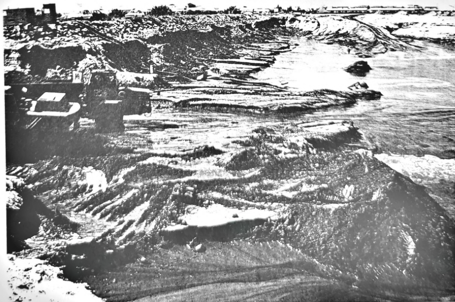
n° 2 : état du site à la fin de l'opération
