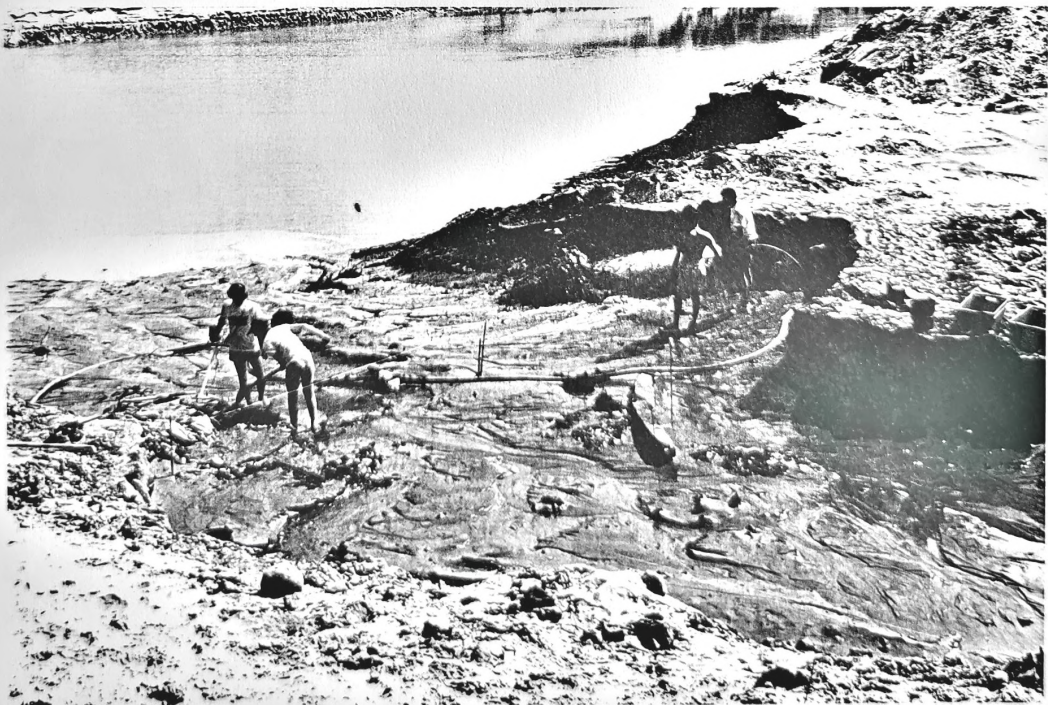
n° 2 : installation du deuxième carroyage
