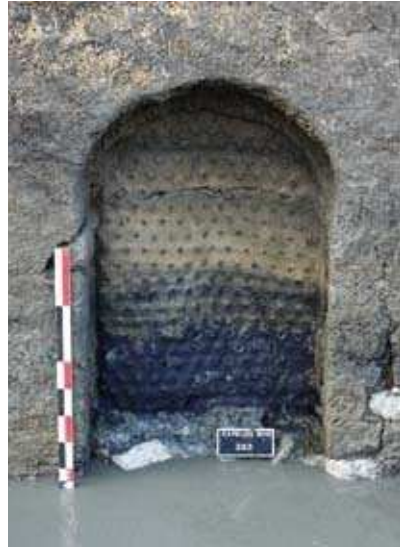
Vue du bassin à abside du triclinium estival depuis l'ouest. On distingue à droite le couvage en bois, à gauche les amphores en saillie faisant office de niche à poissons, en bas le casier à huître et au fond le système de vanne à glissière © N. Carayon
