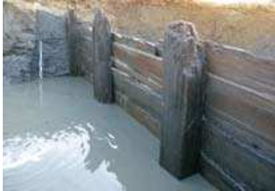
Planches et pieux en bois pour maintenir les sédiments et construire une jetée qui traverse les marécages. Le bois en milieu humide et à l'abri de la lumière est conservé depuis 2 000 ans © C. Sanchez
